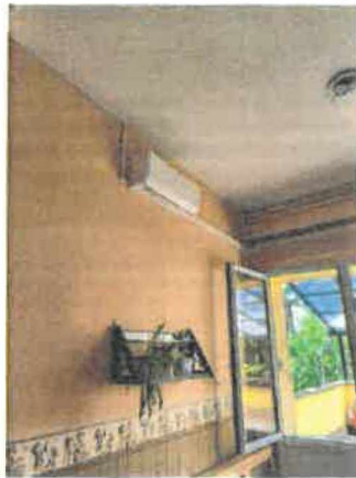
Lovas bölcsőde – klímaberendezés telepítése
