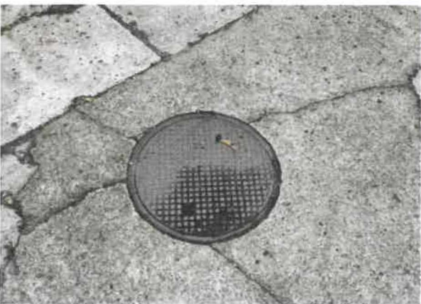
csatornanyílás a telek területén
