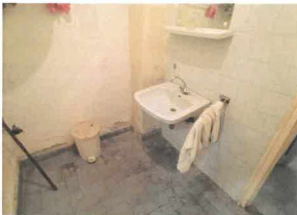
"K" épület - vizesblokk
