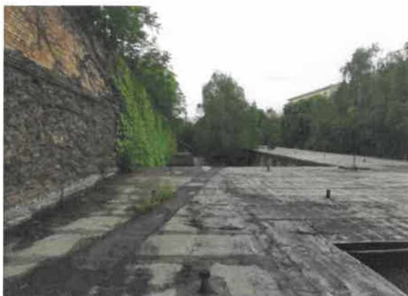
"K" épület tetőszerkezete
