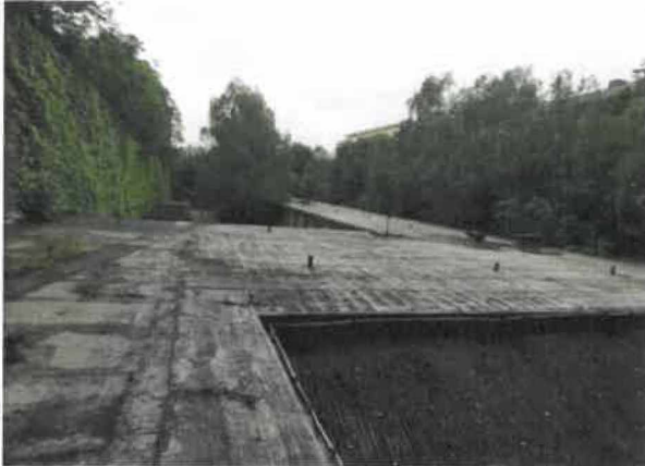
"K" épület tetőszerkezete
