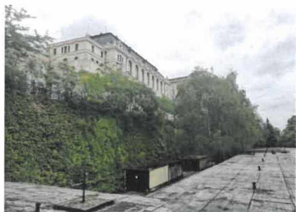
"K" épület tetőszerkezete és környezet
