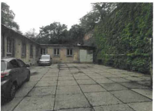
"K" épület keresztszárny
